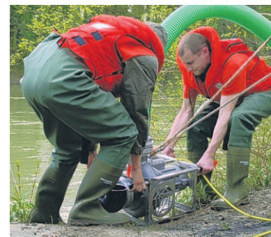
Zwei Pioniere beim Absenken der Tauchpumpe in der Aare. MICHEL DE CIAN
